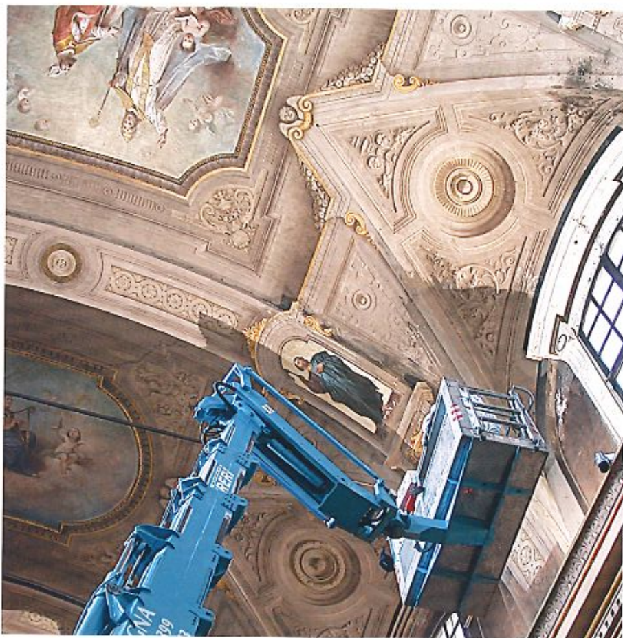
Restauro della volta della chiesa dei Ss. Gregorio e Siro
