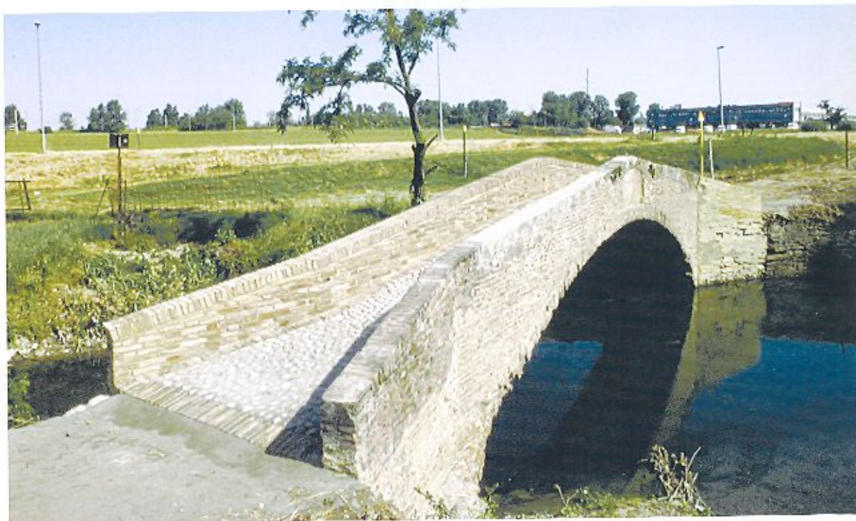
Il Ponte Nuovo detto della Bionda
