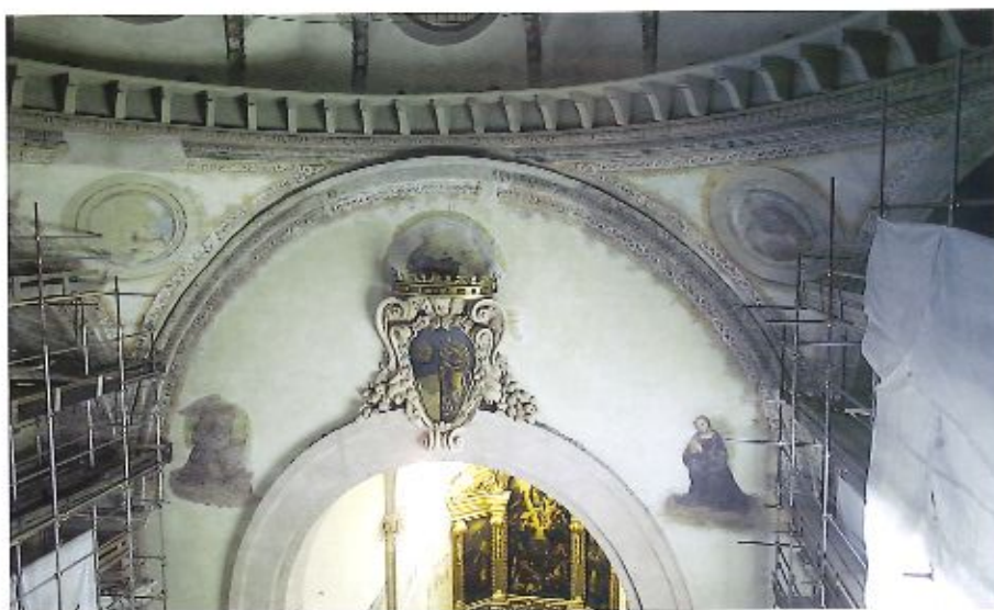
6. RESTAURO DEGLI INTERNI DEL CORO E DELLA CAPELLA MAGGIORE DEL CONVENTO DI S. GIACOMO MAGGIORE.
