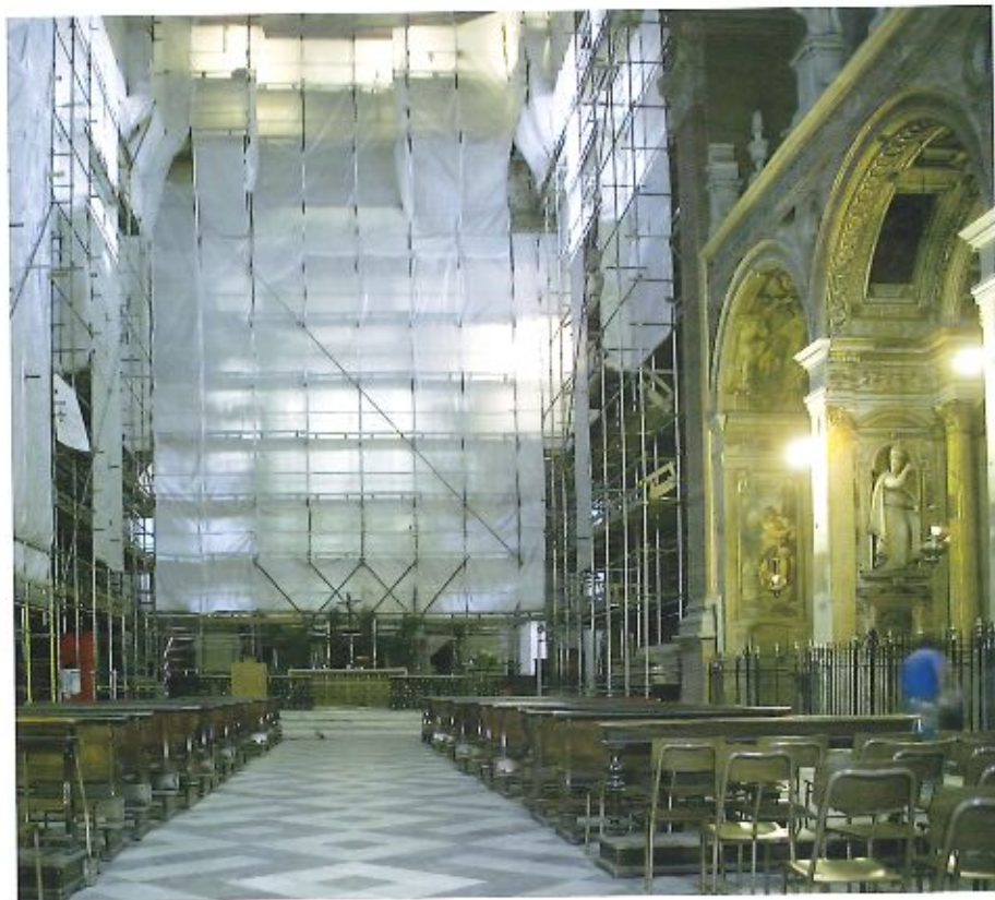
La chiesa di S. Giacomo Maggiore in corso di restauro
