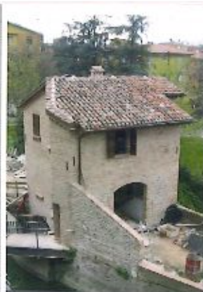
Immagini del restauro conservativo dell'antico paraporto Scaletta ad opera del Consorzio della Chiesa del Reno.
