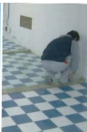
Momenti del progetto "Formazione per ospiti della Fondazione Nuovo Villaggio del Fanciullo Celso e Anna Frascaroli", realizzato dalla Scuola provinciale Edili CPT.
