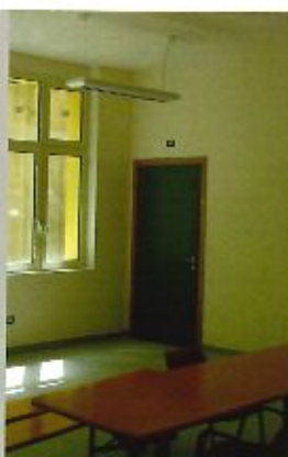
I lavori di costruzione della nuova casa protetta di San Pietro in Vincoli Fondazione San Rocco
