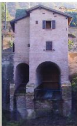
Immagine del restauro eseguito all'antico paraporto Scaletta Consorzio della Chiusa di Casalecchio e del Canale di Reno
